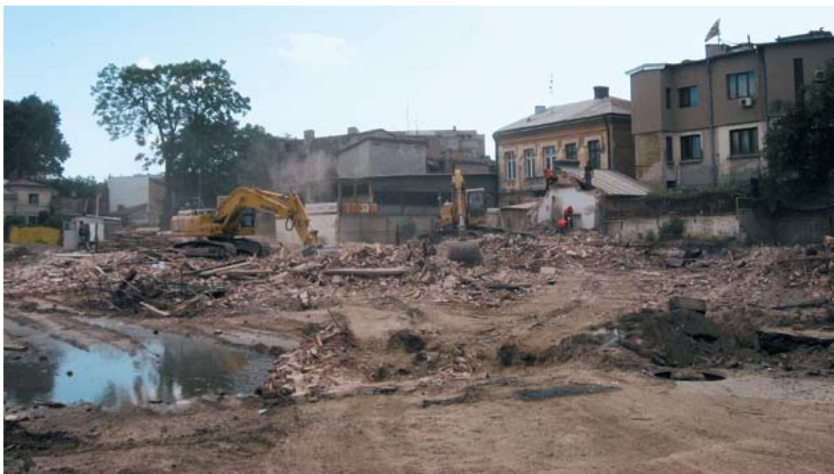
Strada Berzei în șantier, iulie 2011
