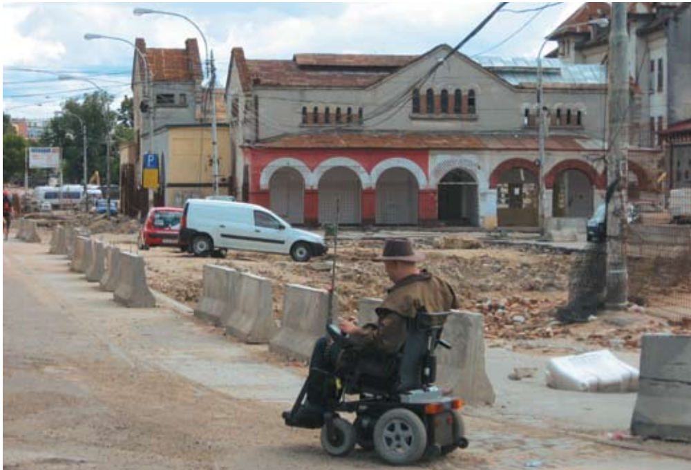
Strada Berzei în șantier, iulie 2011
